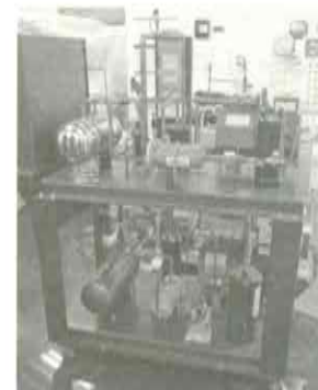
小型二元冷凍機ユニット 上段がCO 2 冷媒、下段がR134a
