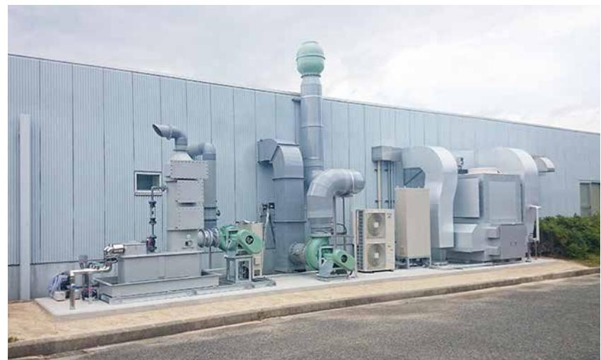
これらの技術が外気処理空調機の給気制御を適切に行い、室内を陰圧に保つことを容易にしました。またこのシステムは、機能性と安全性を高めただけでなく、給気・排気ともに要求に応じてファンをインバータ制御させ、省エネ化を実現しました。
