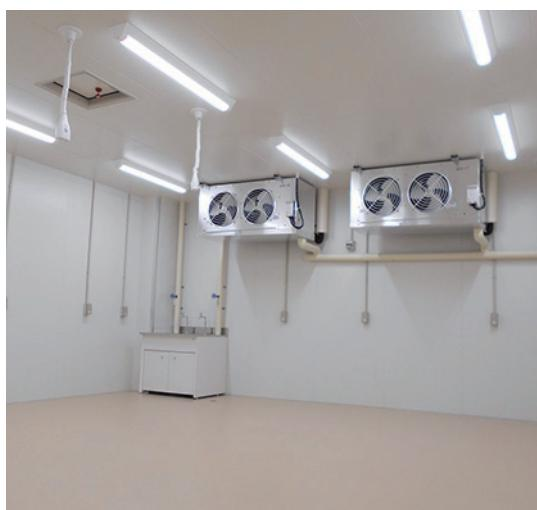
通常はタイマー設定でユニットの交互運転をしていますが、どちらかに故障が発生した場合は、自動で正常なユニットに切替えて運転ができるよう制御し、また停電が発生した時は、停電の復旧時に自動復帰させるように制御しています。
